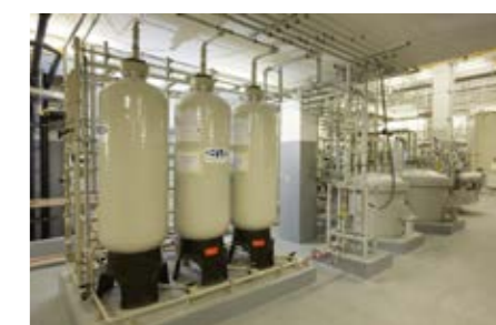
Hg-Ionenaustauscher und Kerzenfilter
